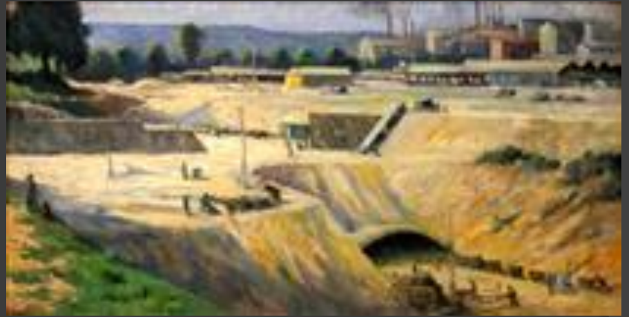
La construction du métro à Issy-les-Moulineaux
