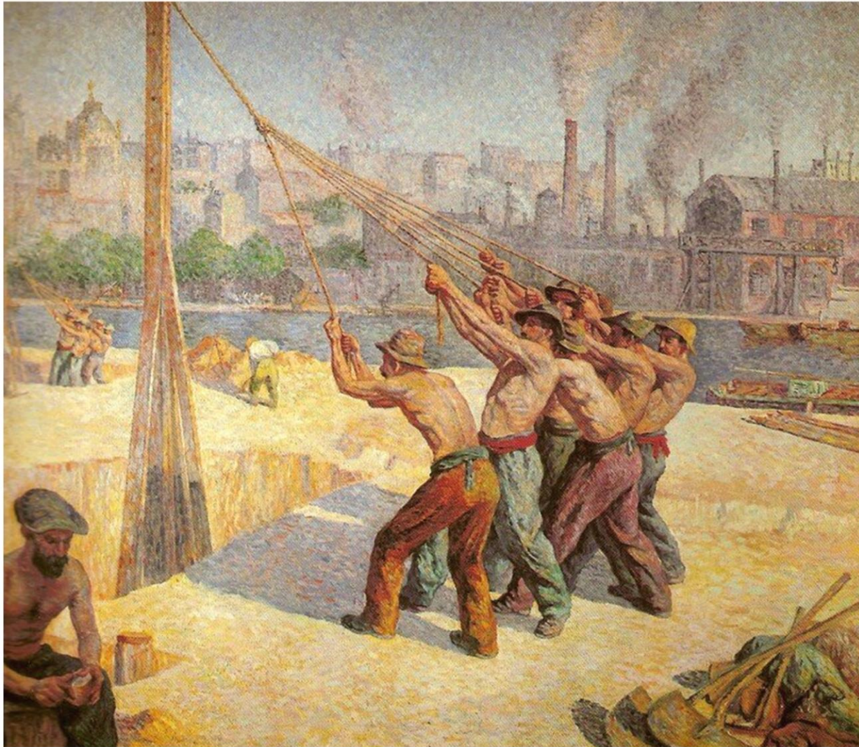
Les batteurs de pieux
