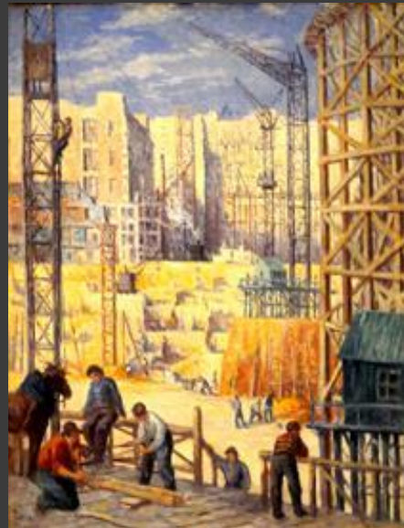
La construction du quai de Passy
