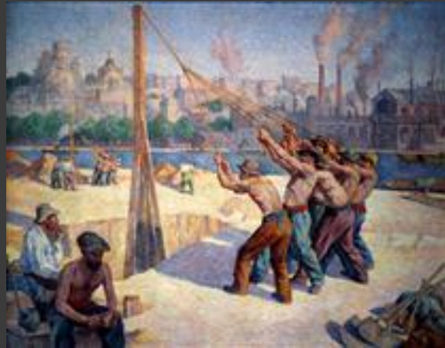
Les batteurs de pieux
